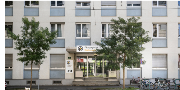
Theodor-Körner-Straße Theodor-Körner-Straße 38, 8010 Graz Gebäudekürzel: T
