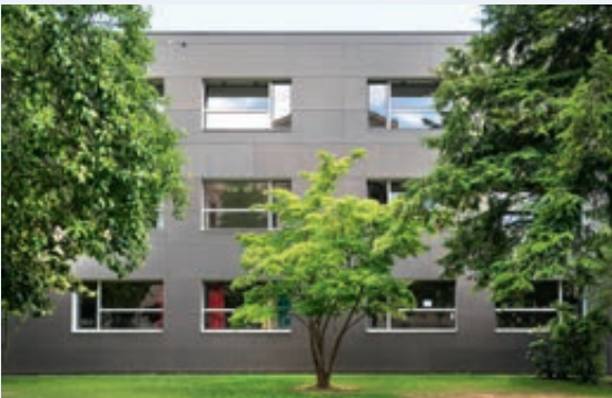
Campus Nord Hasnerplatz Neubau
