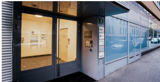
Anzengrubergasse Anzengruber Gasse 6-8, 8010 Graz Gebäudekürzel: Z
