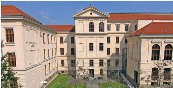
Hasnerplatz Altbau Hasnerplatz 12, 8010 Graz Gebäudekürzel: A
