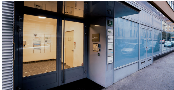
Anzengrurgasse Anzengruber Gasse 6-8, 8010 Graz Gebäudekürzel: Z
