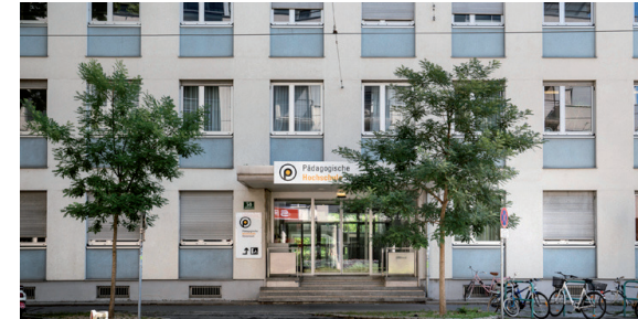
Theodor-Körner-Straße Theodor-Körner-Straße 38, 8010 Graz Gebäudekürzel: T
