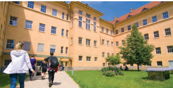
Ortweinplatz Ortweinplatz 1, 8010 Graz Gebäudekürzel: O
