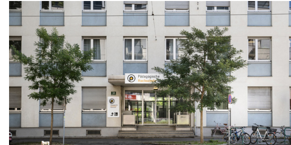
Theodor-Körner-Straße Theodor-Körner-Straße 38, 8010 Graz Gebäudekürzel: T
