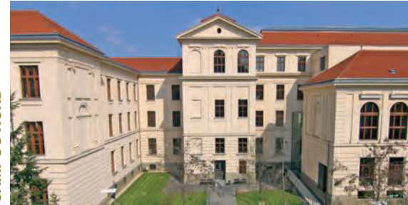
Hasnerplatz Altbau , Gebäudekürzel: A Hasnerplatz 12, 8010 Graz Straßenbahn Linie 3 und 5
