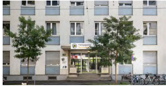
Theodor-Körner-Straße , Gebäudekürzel: T Theodor-Körner-Straße 38, 8010 Graz Straßenbahn Linie 3 und 5
