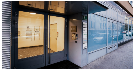
Anzengrubergasse Anzengruber Gasse 6-8, 8010 Graz Gebäudekürzel: Z
