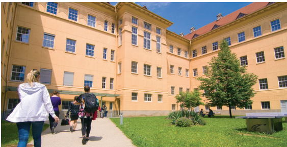
Ortweinplatz Ortweinplatz 1, 8010 Graz Gebäudekürzel: O
