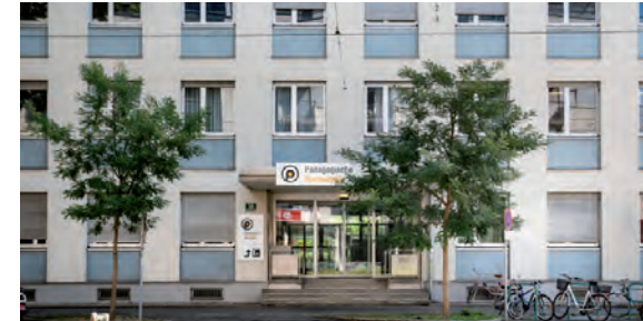
Theodor-Körner-Straße Theodor-Körner-Straße 38, 8010 Graz Gebäudekürzel: T
