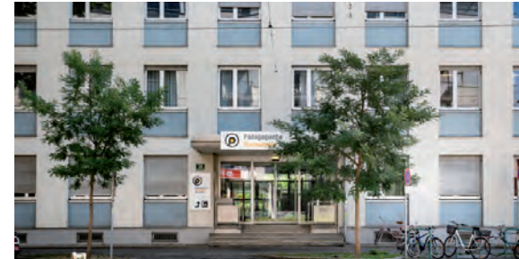
Theodor-Körner-Straße Theodor-Körner-Straße 38, 8010 Graz Gebäudekürzel: T
